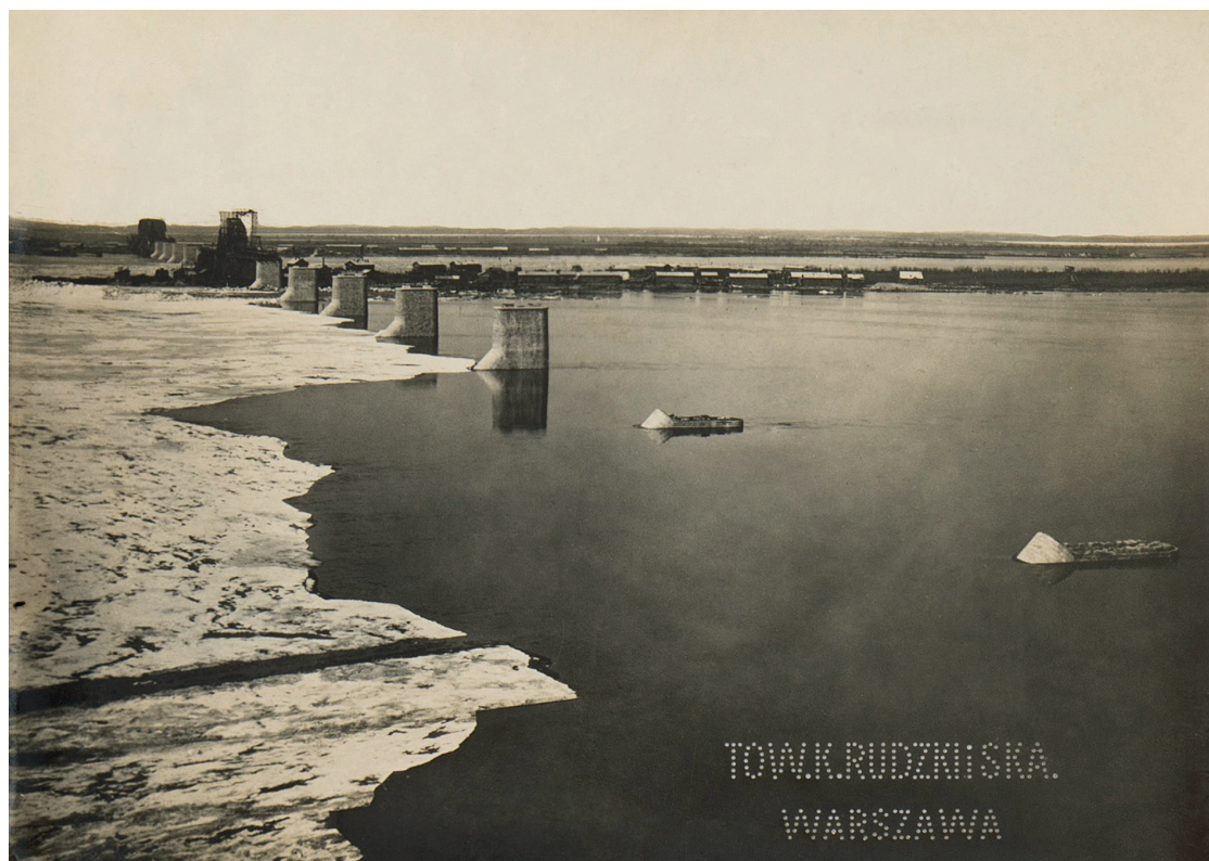
Rys. 7. Ogólny widok budowy mostu Amurskiego (Dom Aukcyjny Ostoya [41] oraz [1, s. 99]). Niektóre filary są już gotowe, a inne w trakcie konstrukcji. Widać też pojedyncze przęsła. Patrz także ilustracje w [24, 26, 42, 9, 43]
