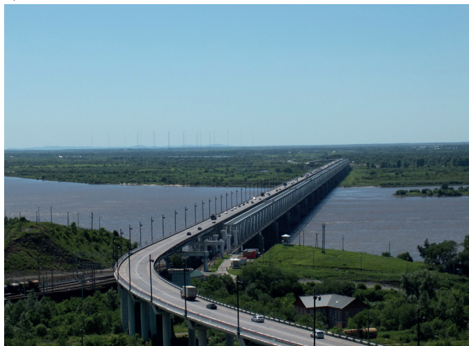
Rys. 13. Widok mostu w Chabarowsku: a) po zakończeniu pierwszego etapu przebudowy i demontażu historycznych przęseł (Wikimedia Commons [54]), b) obecnie (Wikimedia Commons [55])
