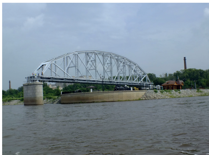
Rys. 12. Jedno z 18 dużych przęseł historycznego Mostu Chabarowskiego zachowane w Muzeum Historii Mostu Amurskiego w Chabarowsku (Wikimedia Commons [53], patrz także [24])
